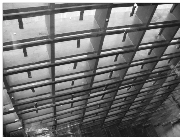
Figura 2. Estrutura dos LED's fixada na grelha de madeira do edifício.
