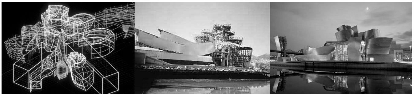
Fig. 1. Em sequência: o modelo virtual - CATIA, o processo de construção e o edifício construído. Fonte: Montagem a partir de imagens obtidas respectivamente nos sites: moreaadesign.wordpress.com; arcspace.com e archdaily.com, 2012
